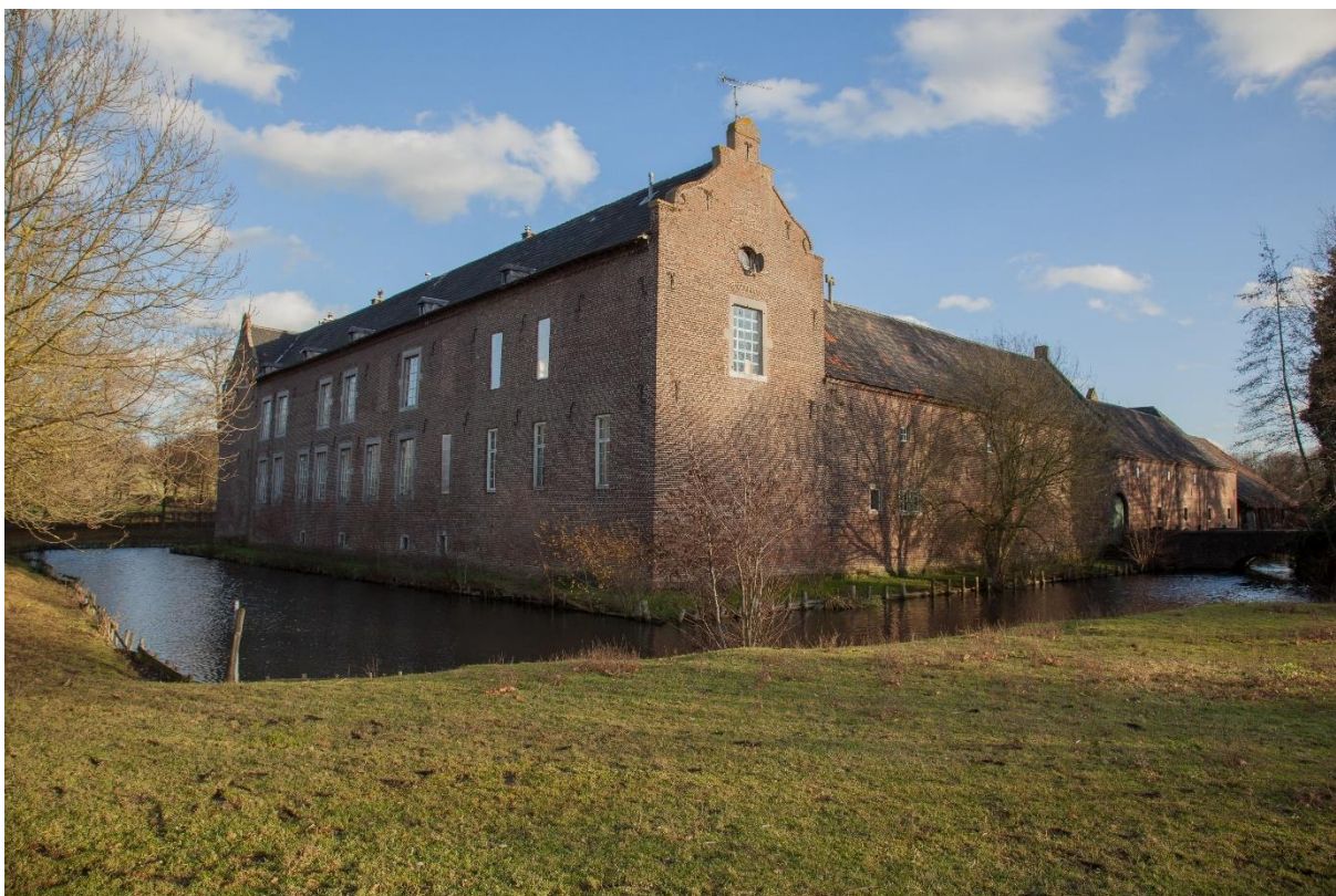
Kasteel Ter Borch. Bron: Beeldbank RCE.
