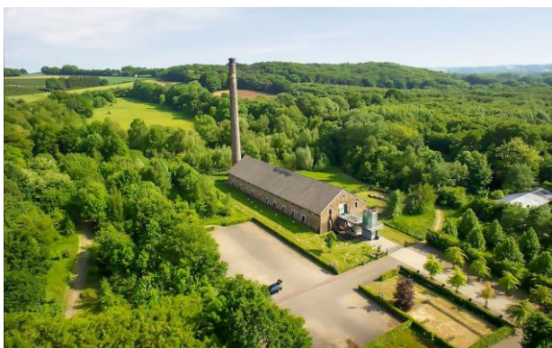
Voormalige steenfabriek in Sweikhuizen
